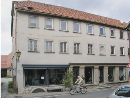
Ansicht vor der Sanierung
