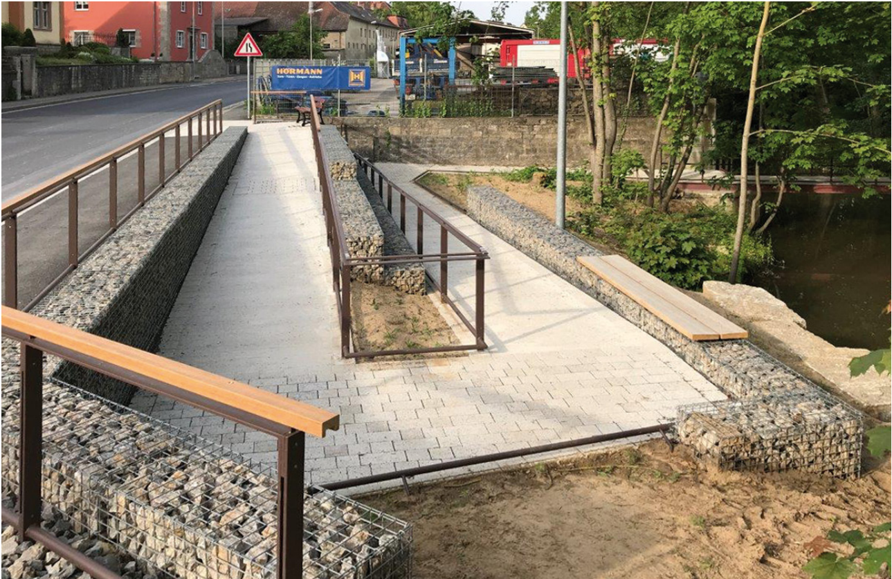
Barrierefreie Zuwegung zum neuen Fußgängersteg
