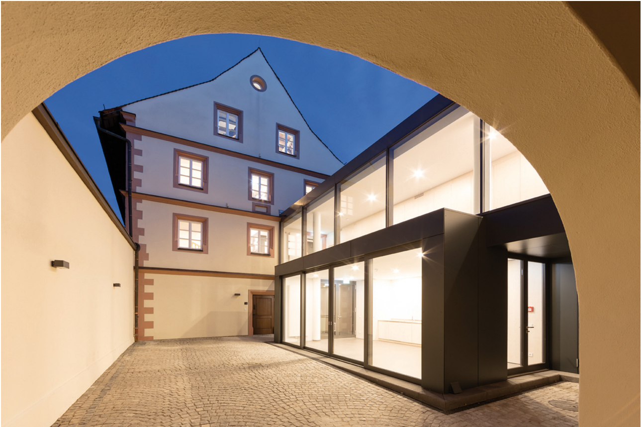
Die „Alten Schranne“ mit der neu konzipierten Ausstellung und dem modernen Verbindungsbau
