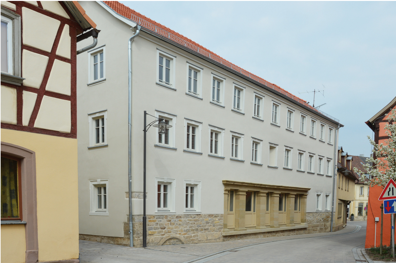
Ansicht vom Marktplatz nach der Sanierung
