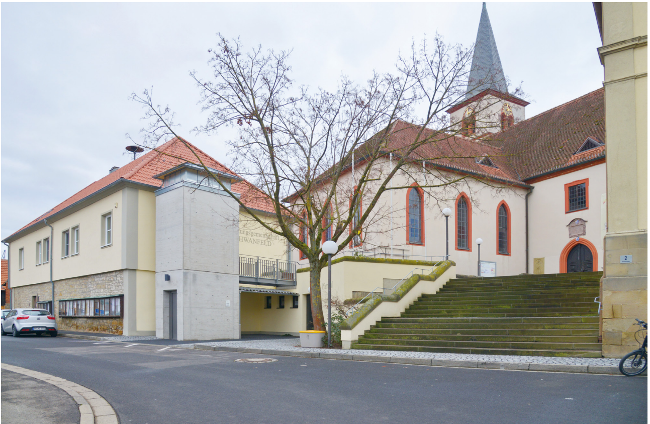
Barrierefreie Erschließung des Rathausumfelds nach Neubau des Aufzugs
